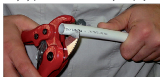
1. Kolmé odstříhnutí trubky.
