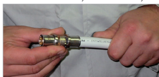
2. Správné hloubkové osazení tvarovky a následné zalisování.
