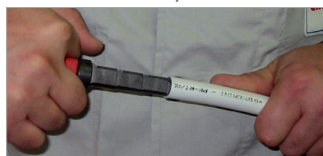
3. Vykaličování a ořezání vnitřních hran trubky.
