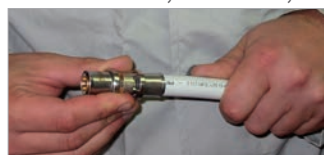
6. Správné hloubkové osazení tvarovky a následné zalisování.
