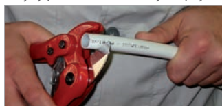
1. Kolmé odstříhnutí trubky.
