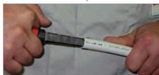
3. Vykalibrování a ořezání vnitřních hran trubky.
