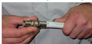
2. Správné hloubkové osazení tvarovky a následné zalisování.
