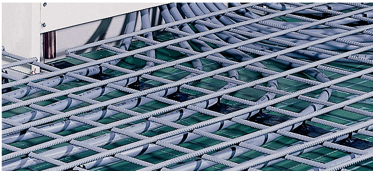
Obr. 2 - Podlahové vytápění s vodícími lištami K390, objímkami K392 a armaturou
